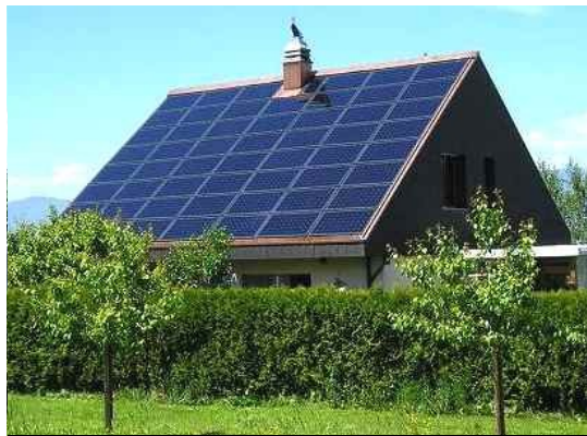
Solar panel included in roof structure Panou solar inclus în structura acoperișului
