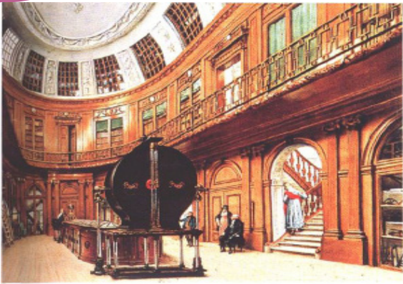
Dans cette salle du Teylers Museum, à Haarlem (Pays-Bas), on voit au premier plan la grande machine électrostatique de Van Marum, dont les disques en verre étaient protégés par des boîtes en bois semi-circulaires. Wybrand Hendricks, La pièce ovale du Teylers Museum, vers 1810.
